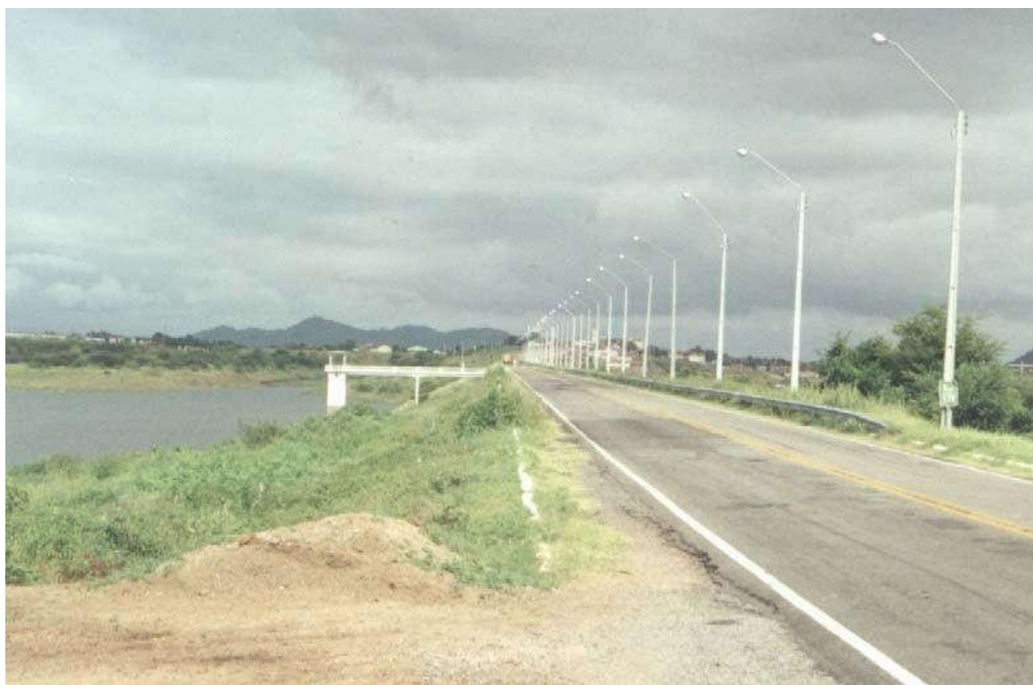
Barragem do Açude Engº Arcoverde
