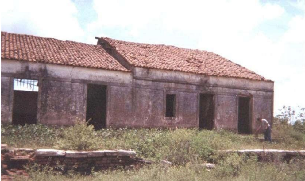
Antigo prédio da usina Dantas & Dodô
